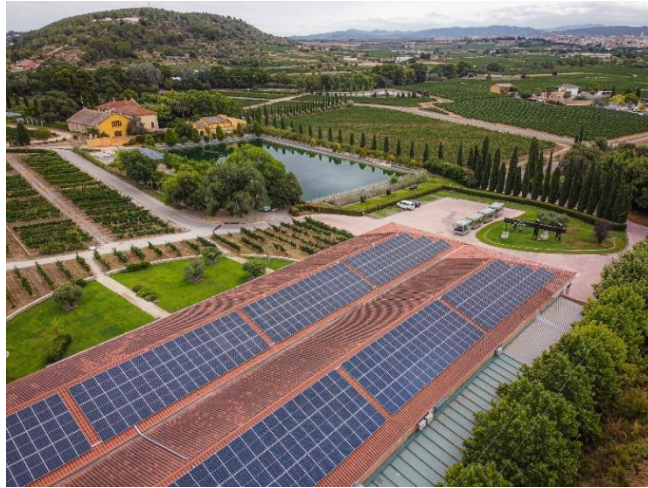
Figura 10. Instalaciones fotovoltaicas de la familia Torres. Fuente: Familia Torres
