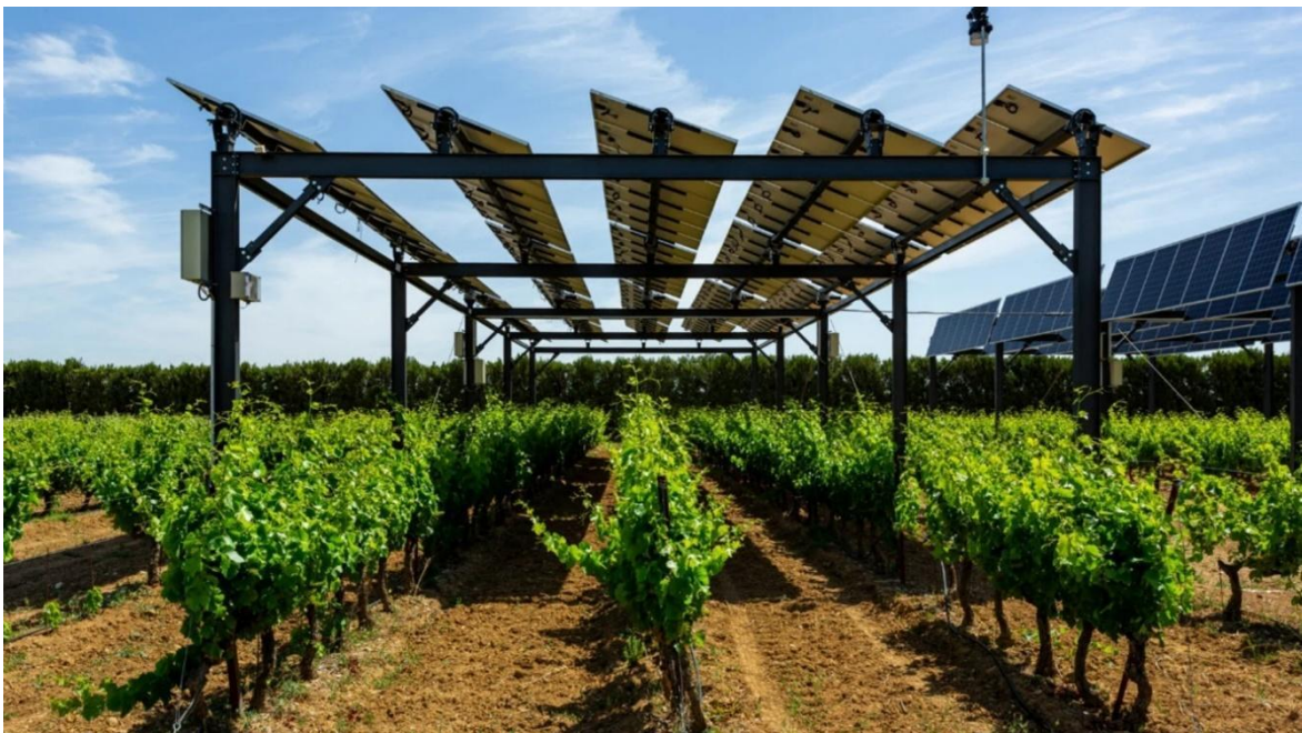
Figura 15. Instalación del "sombreado inteligente" de la bodega San Gabriel. Fuente: Laura Cano Liébana, 2022
