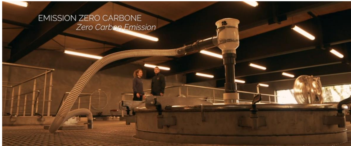
Figura 12. Colector de CO2 para procesos de fermentación. Fuente: Château Smith Haut Lafitte
