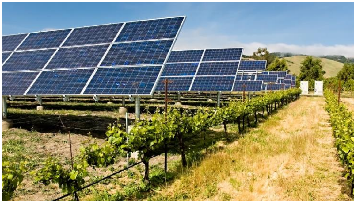
Figura 16. Agrivoltaicos. Fuente: Iberdrola
