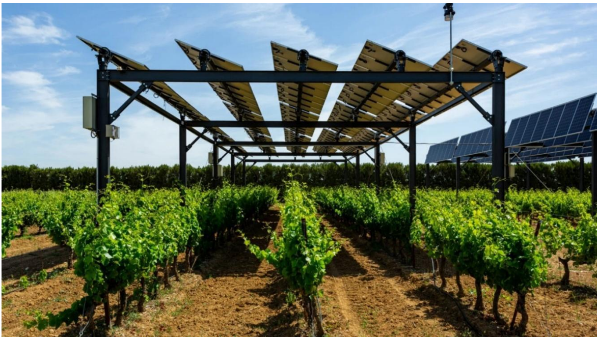
Figure 15. Installation du « système d'ombrage intelligent » de la cave San Gabriel. Source : Laura Cano Liébana, 2022
